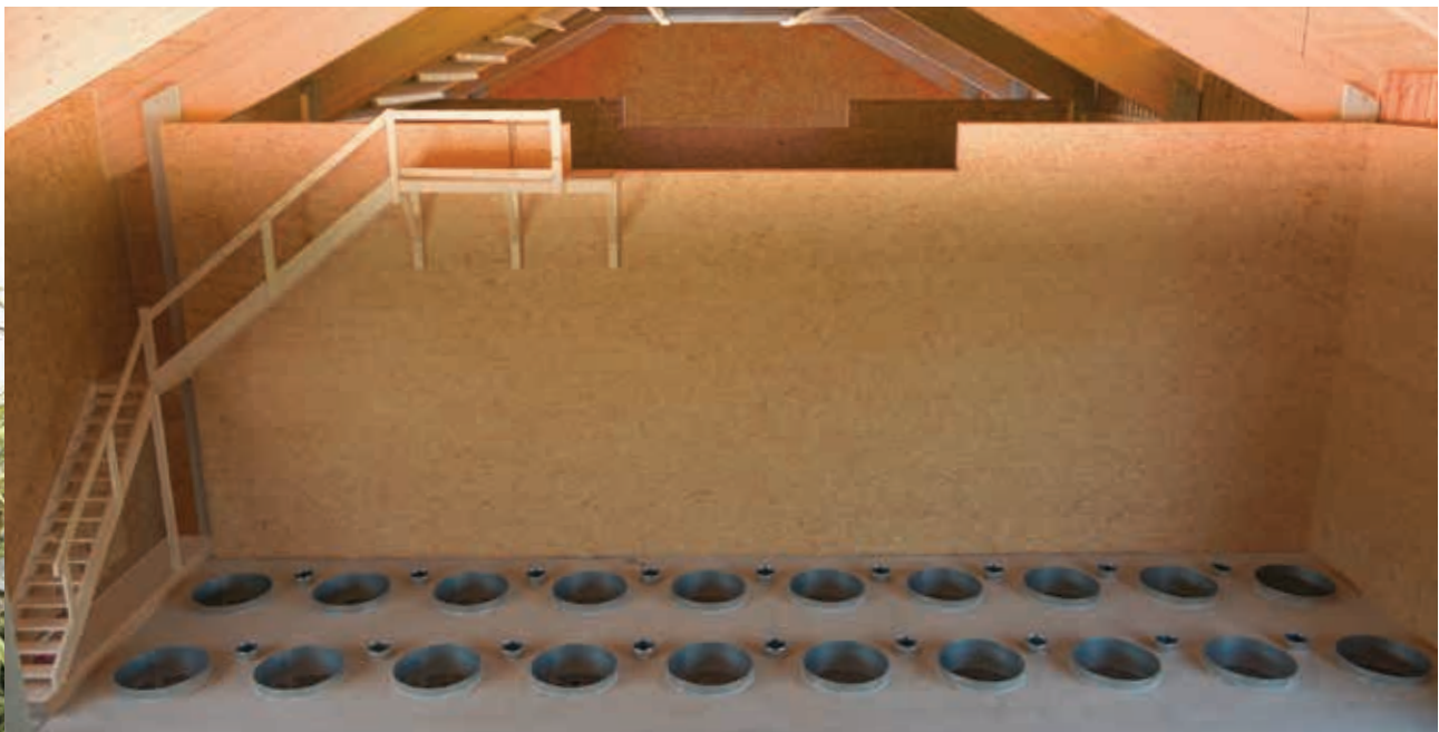
Séchage de balles rondes (système Kombi-Flex) combiné à un séchoir en grange.
